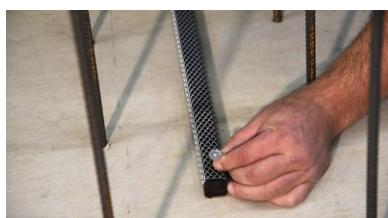
Das Quellbandgitter fest über das **MASTERSTOP Bentonitquellband** legen und mit Nägeln auf dem Beton befestigen. Das Nageln kann händisch oder mit einem Bolzensetzgerät erfolgen. Der Nagelabstand darf nicht größer als 20 cm sein.
