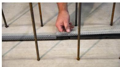
Bei Stumpfstoßen in der Geraden und der Verwendung von Quellbandgittern sollten die Stöße von Quellband und Quellbandgitter versetzt ausgeführt werden.
