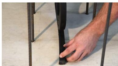
Nach dem Aufbringen des Quellbandklebers, wird das **MASTERSTOP Bentonitquellband** auf den Kleber aufgelegt und gleichmäßig angedrückt. Hierzu sollte das **MASTERSTOP Bentonitquellband** leicht hin und her, quer zur Längsachse, bewegt werden. Der Kleber sollte im Endzustand leicht an beiden Seiten herausquellen. Dies garantiert eine vollflächige Fixierung. Gebrauchsfest nach ca. 4 - 6 Stunden ( je nach Witterung )
